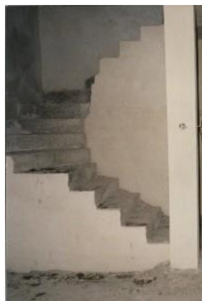
Schody rozliczone, jak za powierzchnię mieszkalną
